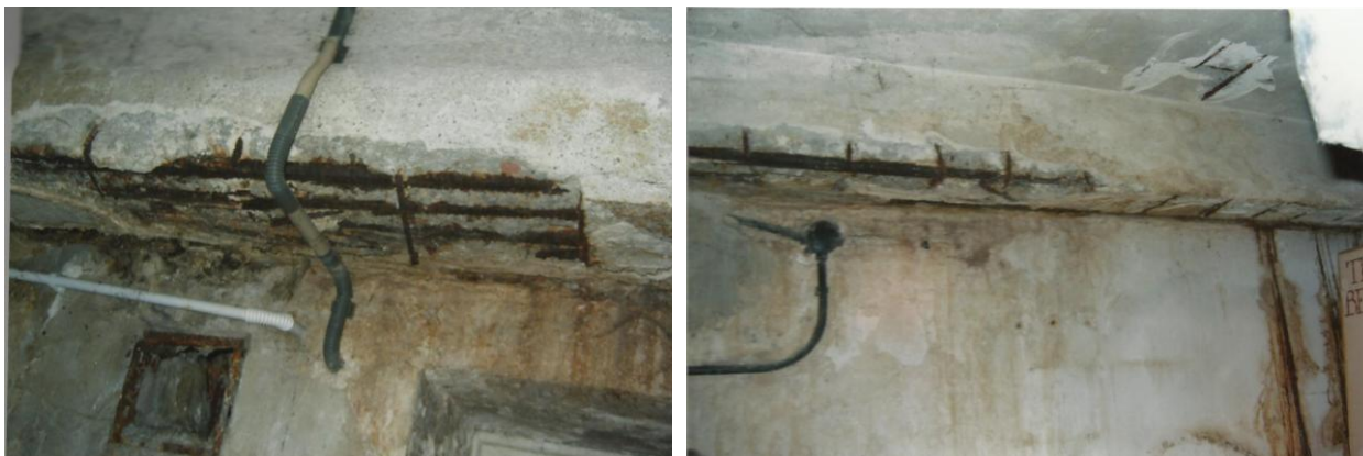
Ryc. 6-1 Skorodowane podciągi i żebra w pomieszczeniach piwnicznych według Opinii Technicznej z 2006r. {1}
