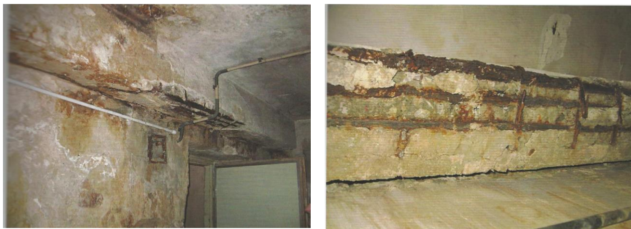
Ryc. 6-2 Skorodowane podciągi i żebra w pomieszczeniach piwnicznych według Orzeczenia z 2009r.
